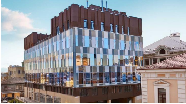
Строительство офисного здания со встроенным паркингом
