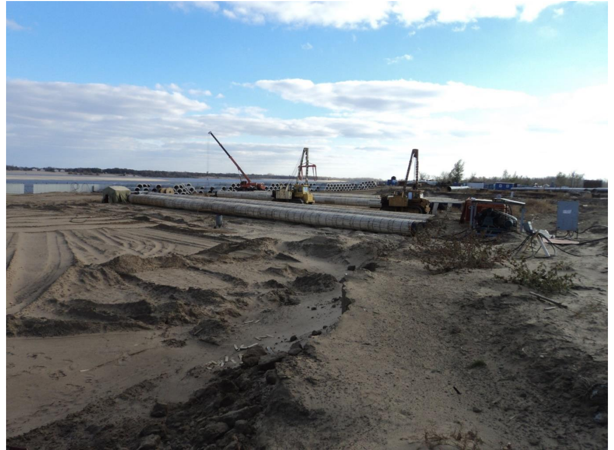
Строительный контроль за строительством подводного перехода канализационных коллекторов через р. Волга в г. Волгограде.
