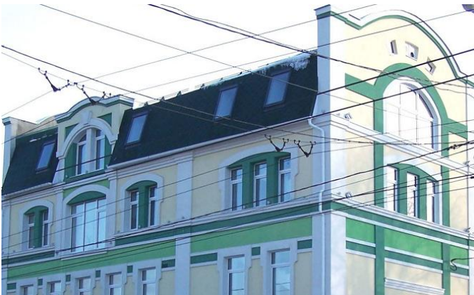
Реконструкция здания с надстройкой мансардного этажа
