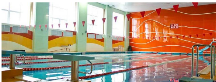
Реконструкция и отделочные работы здания бассейна в фитнес-клубе «Олимпия»
