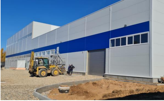
Строительство производственно-складского комплекса по ул. 23-Линия
