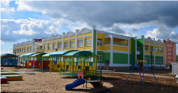
Строительство детского сада
