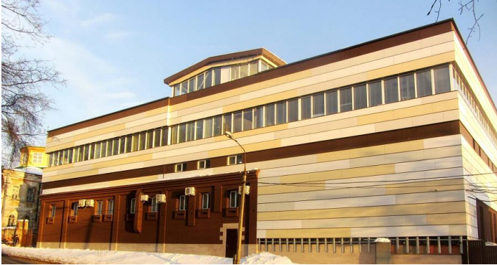
Реконструкция здания с расширением под швейное производство
