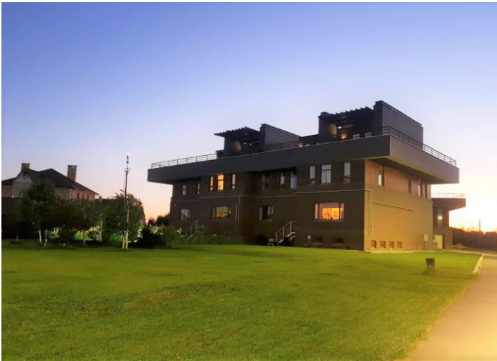
Строительство коттеджного комплекса, состоящего из шести загородных домов премиум-класса
