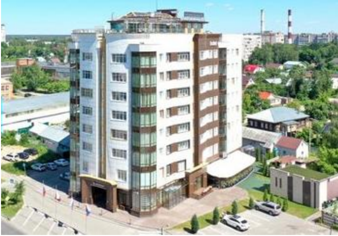
Строительство гостиницы «Best Western»
