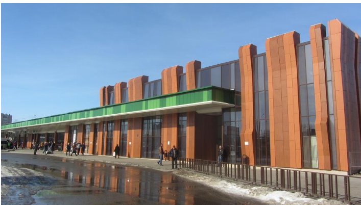
Реконструкция здания и перрона автовокзала
