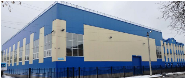
Строительство крытого зала для футбола с административно-бытовым комплексом на территории
