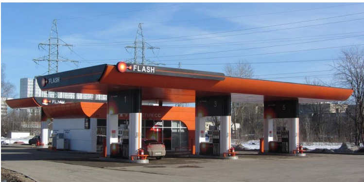
Строительство автозаправочной станции
