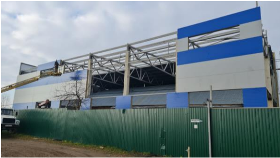
Реконструкция с расширением производственного здания
