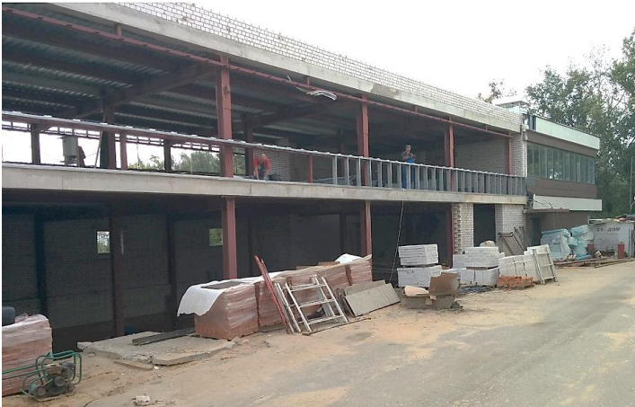
Строительство складского комплекса под нужды швейного производства
